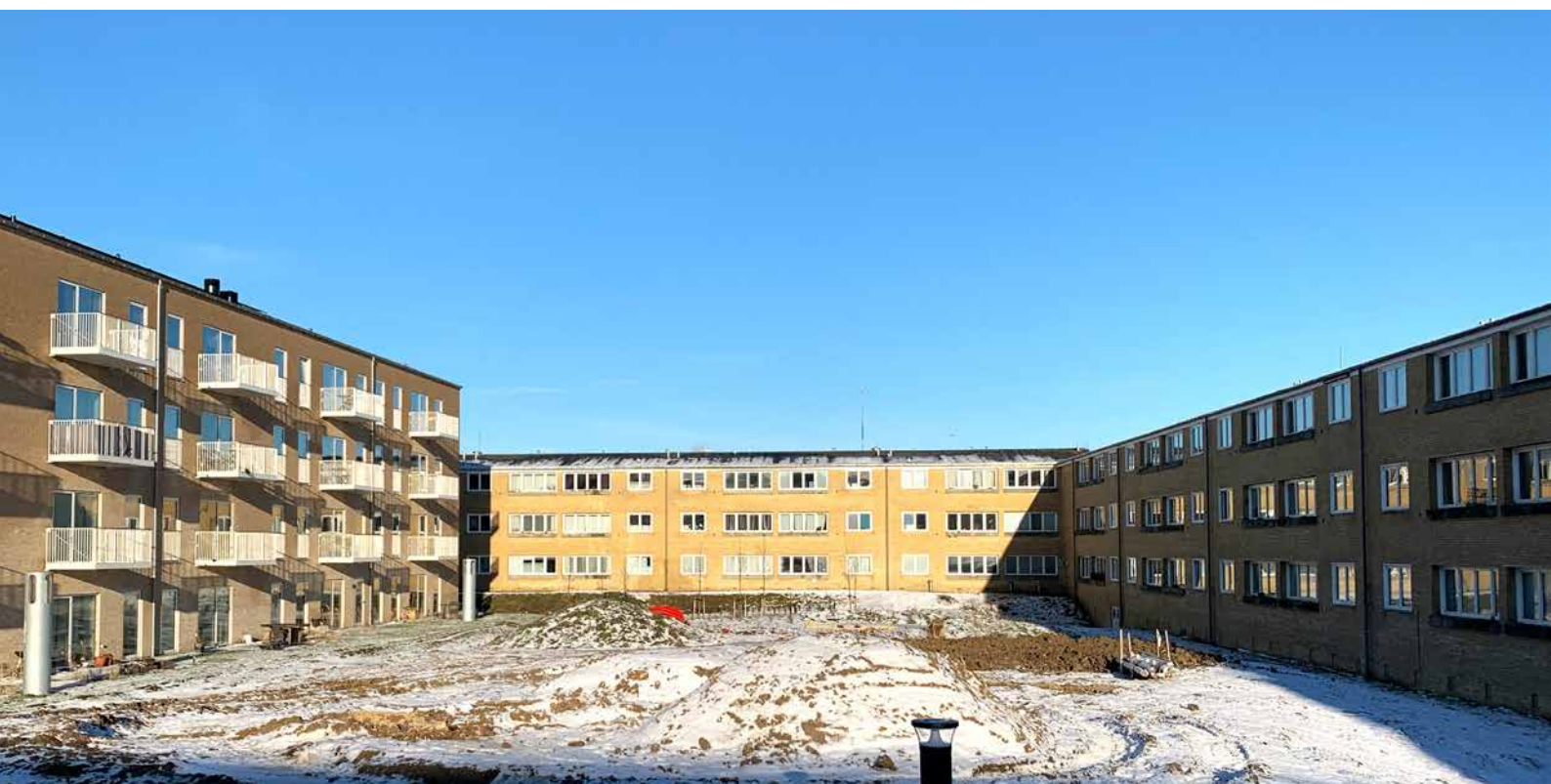
Nyt gårdrum med plantekasser og opholdsrum mellem almene boliger (i midten og til højre) og nye, private udlejningsboliger (til venstre). Ruten, Tingbjerg, 2024.
