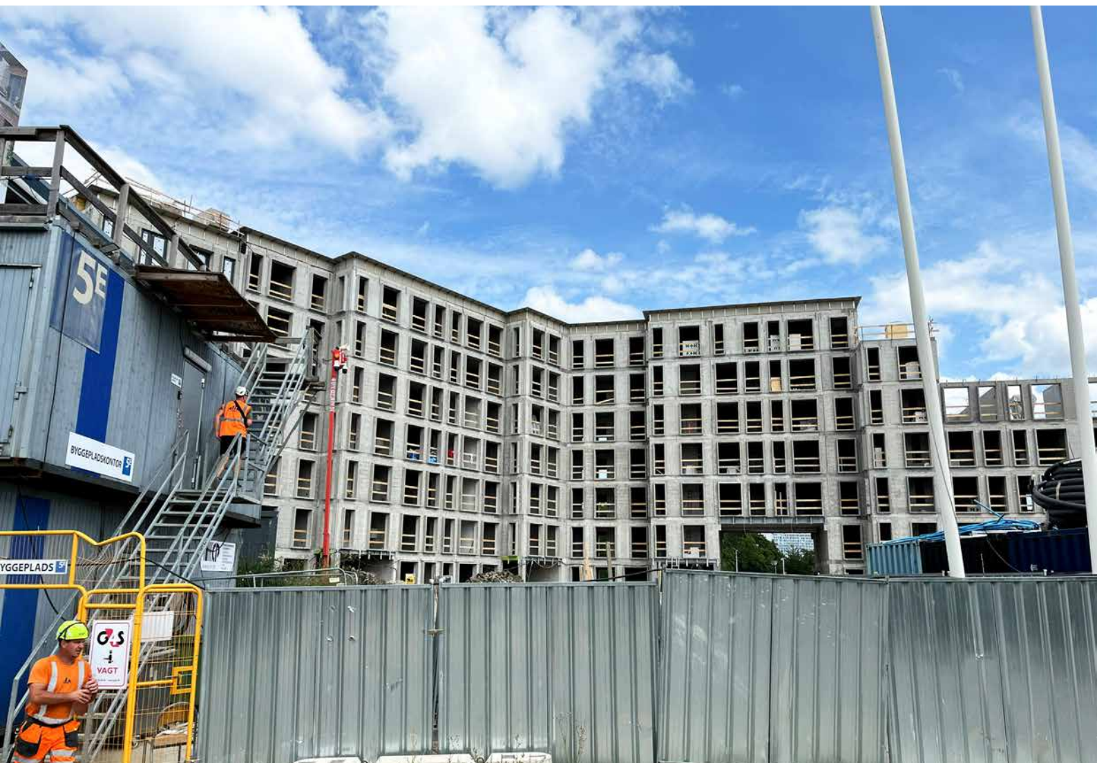
Nye, private udlejningsboliger, Tingbjerg Ås, 2024.
