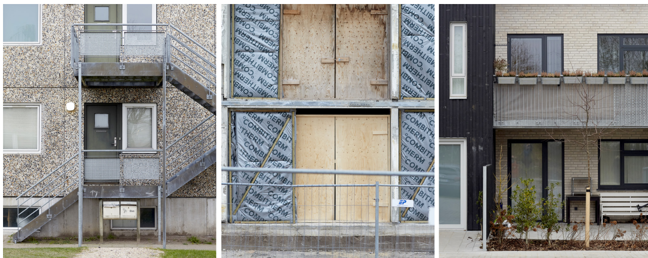
Allborg Øst før, under og efter renoveringen.
